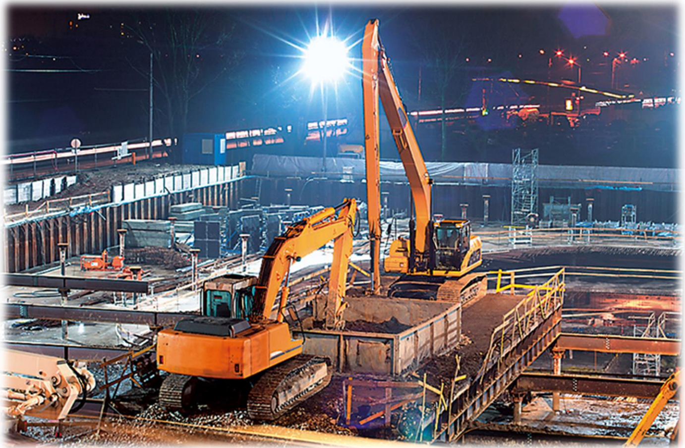
نمونه ای از نورپردازی در کارگاه های ساختمانی
