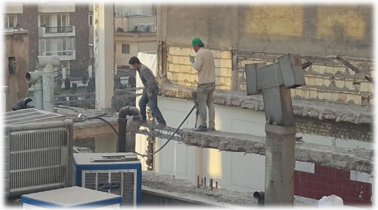
نمونه‌ای از عملیات تخریب ناایمن
