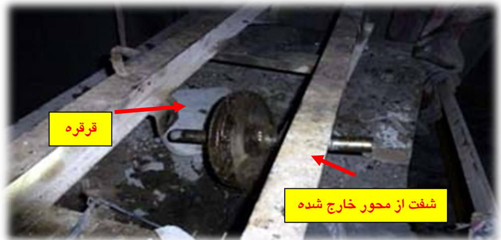
شکل ۷- قرقره و شفت از محور خارج شده بالابر حادثه دیده
