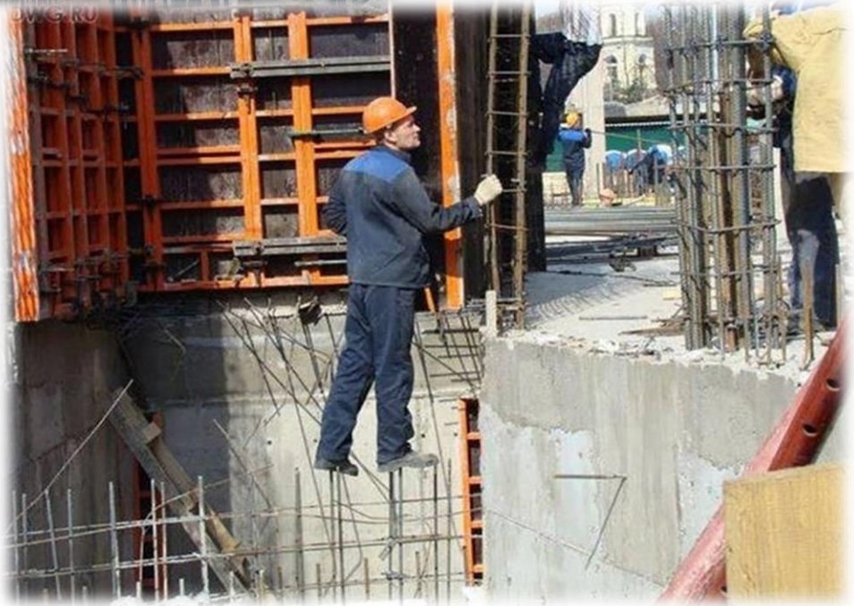
نمونه ای از کارهای نایمن در آرماتوربندی
