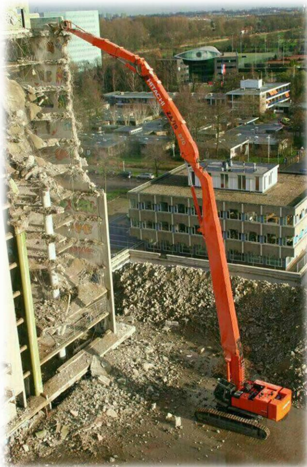
نمونه‌ای از عملیات تخریب ناایمن
